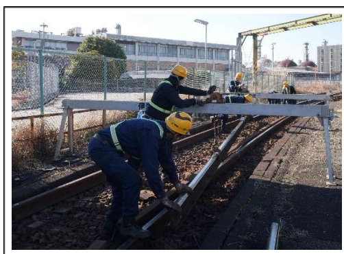
レール交換作業
