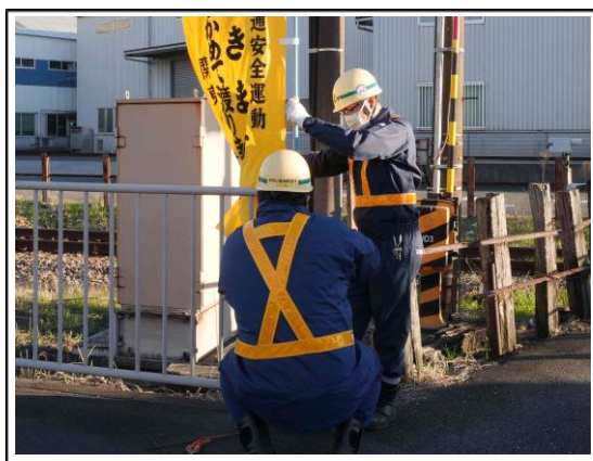
地域の皆様への注意喚起のノボリを設置
