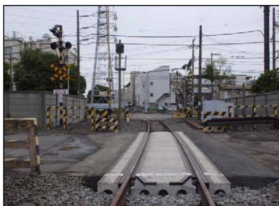
接続軌道化を行った千鳥線東電変電所南側踏切
