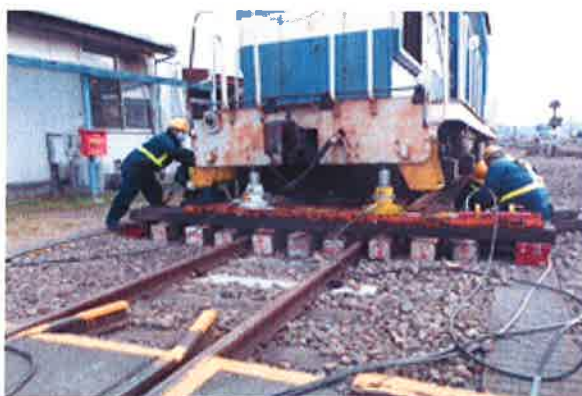
脱線した機関車をジャッキで持ち上げて横移動させてレール上に載線させる訓練風景
