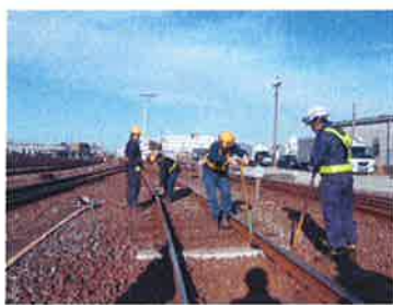
※木製枕木からPC(コンクリート)枕木への交換作業
