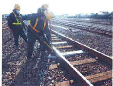
※木製枕木からPC(コンクリート)枕木への交換作業
