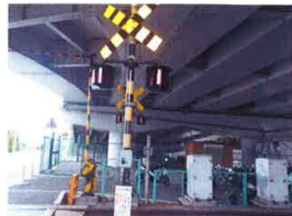
※踏切警報灯を視認性の高い全方向形に交換
